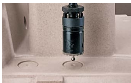
B - Posizionare la fresa in corrispondenza del preforo
